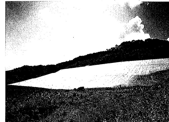
北陸農政局＝五位ダム押え盛土のり面保護工 (FP100NRJ)
