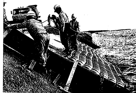
沖縄県＝糸満港防波護岸工 (CX500)
