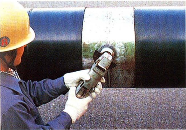
1:パイプのクリーニング。 ワイヤーブラシ等でうきサビを落します。
