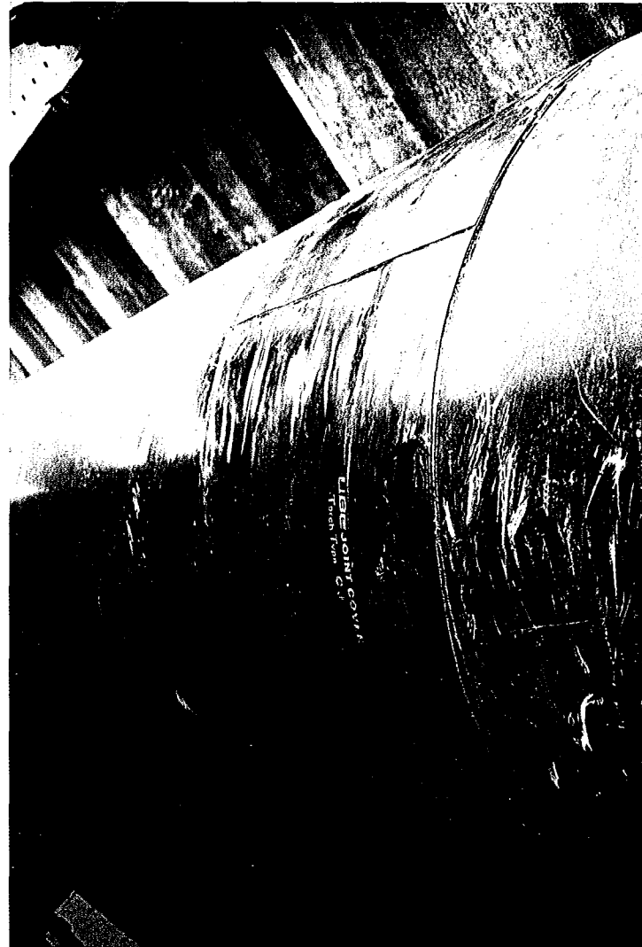
上水道送水管
