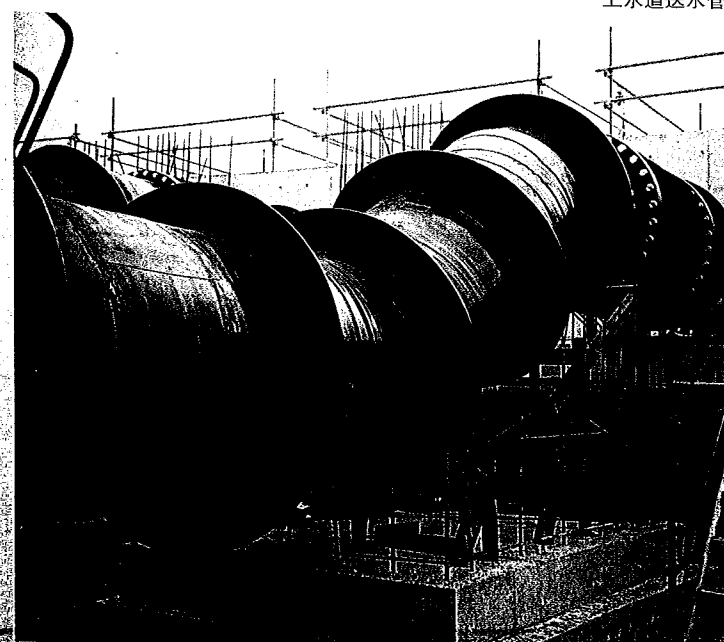
発電所循環水管
