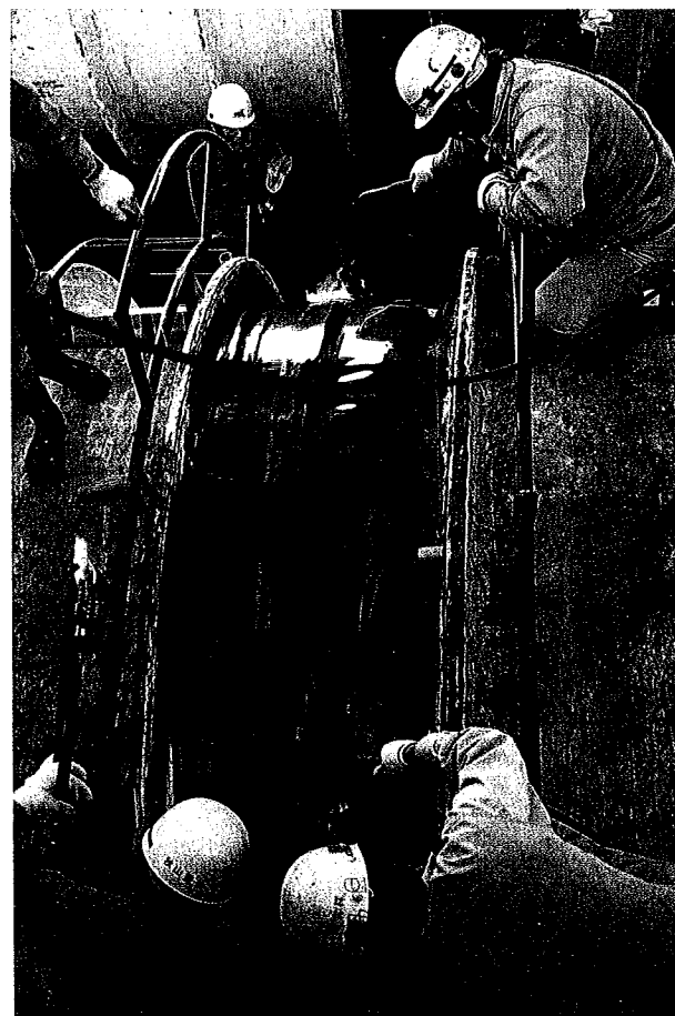
流況調整河川導水路
