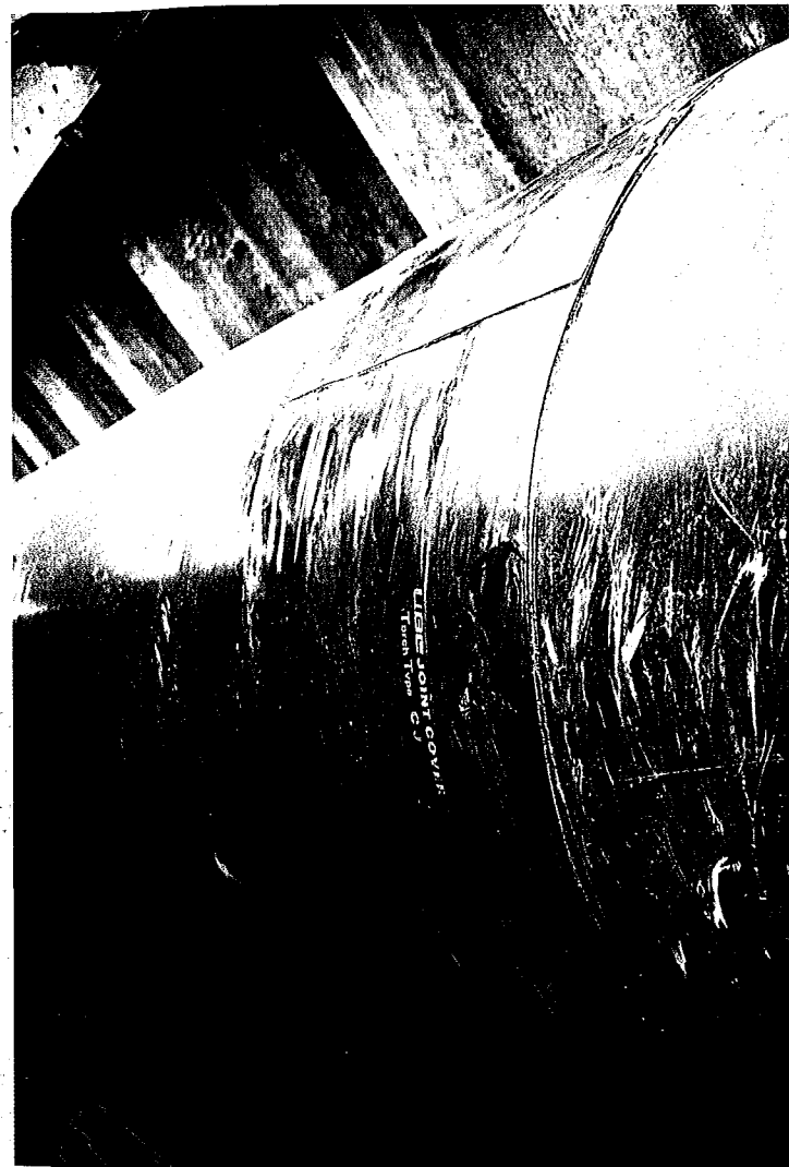
上水道送水管
