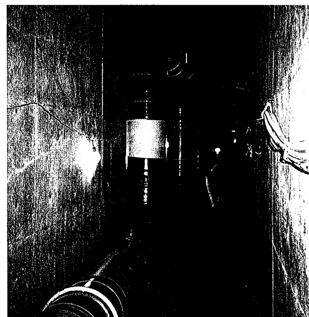
中圧ガス本管
