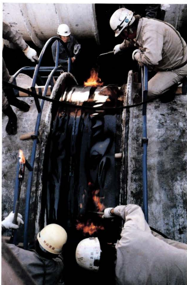
流況調整河川導水路
