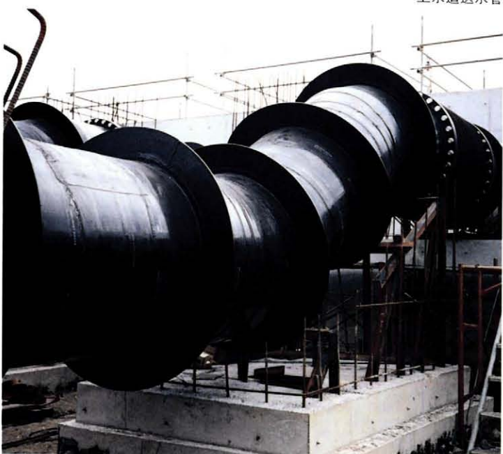
発電所循環水管
