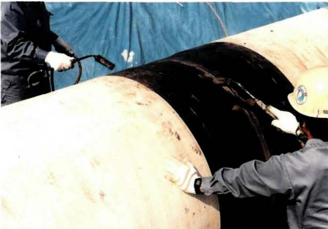
2:パイプの予熱。 専用プロパントーチを使用します。
