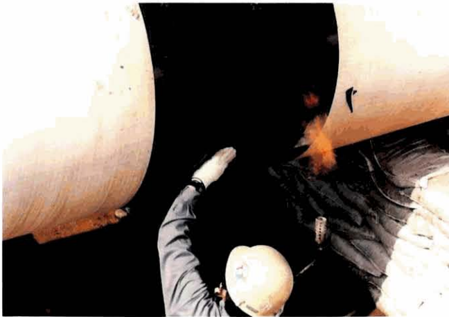
5:収縮。 中央部から一方の端に向かい空気を追出すように収縮させ、最後に残りの片側を収縮させます。
