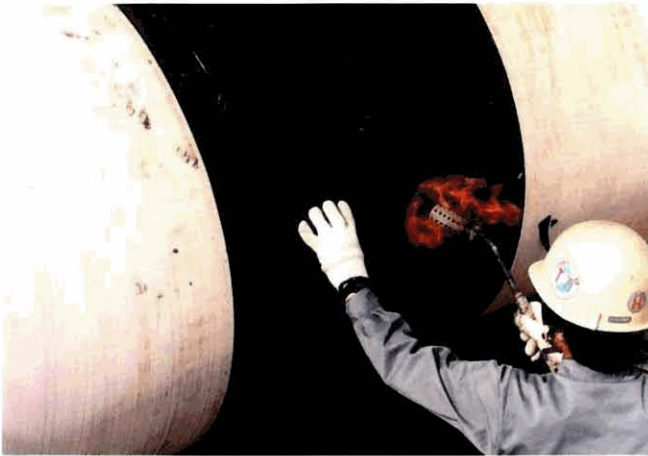
4:ヒートシールテープのセット。 ヒートシールテープの表面の黄色塗料が灰色に変色するまで加熱します。
