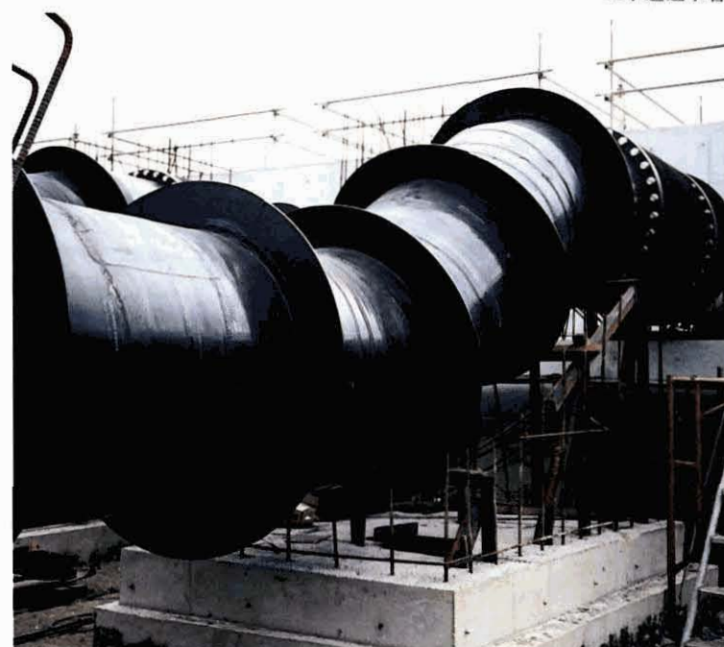
発電所循環水管
