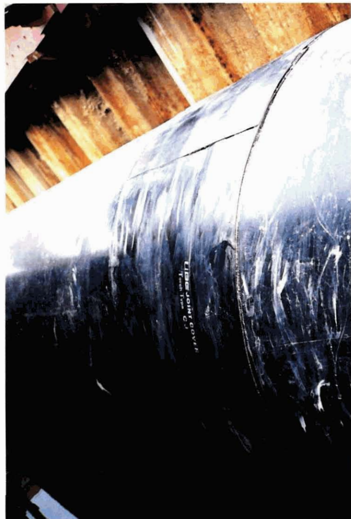
上水道送水管
