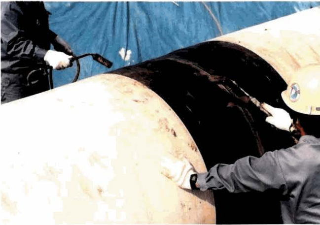
2:パイプの予熱。 専用プロバントーチを使用します。
