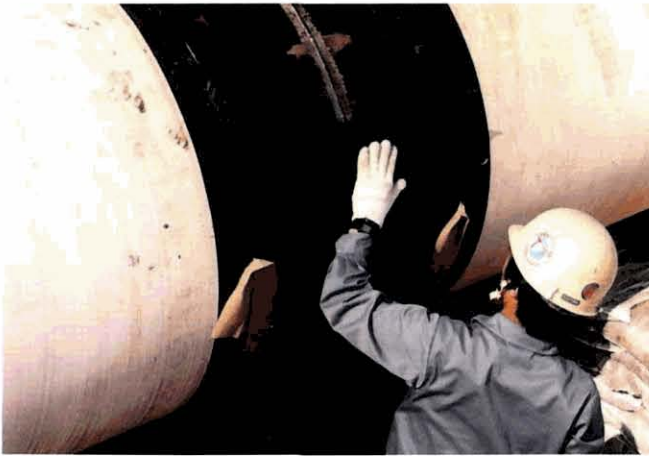
3:ジョイントカバーのセット。 離形紙をはぎながらセットします。
