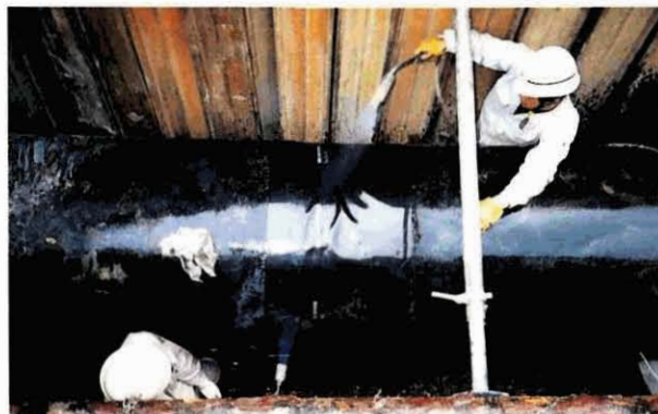
上水道送水管
