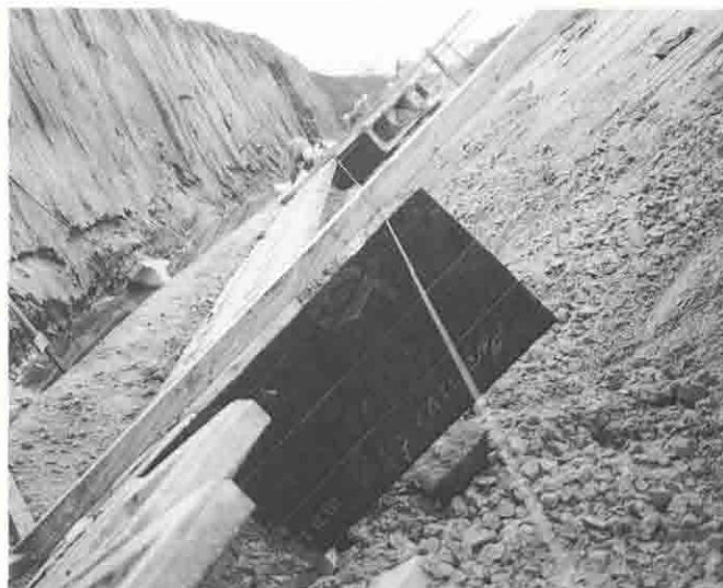
擁壁にケンタイト使用
