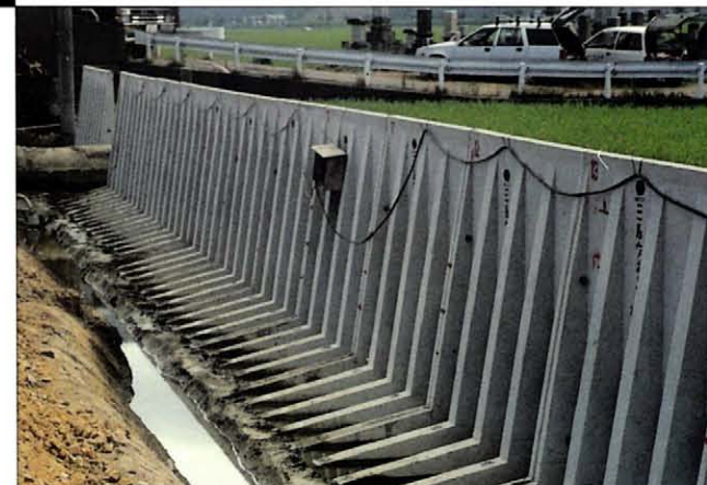
国道拡幅工事
