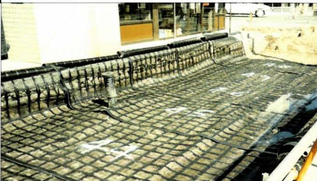
国道改良工事
