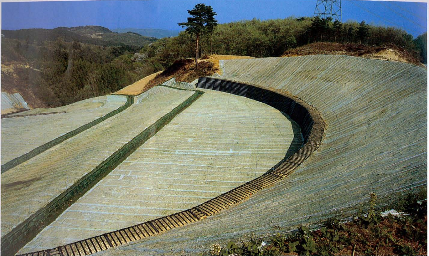
工事名：東広島研究団地土地造成工事(広島県)
