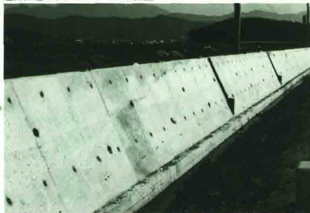
宅地造成工事のブロック積み擁壁
