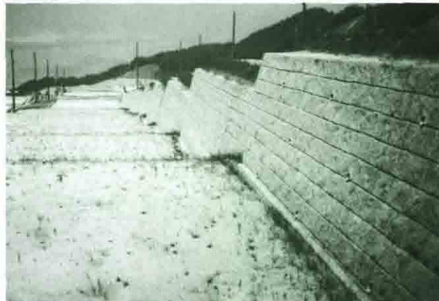
高速道路のもたれ擁壁、コンクリート吹付擁壁
