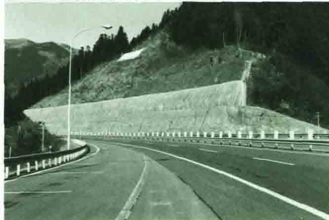
高速道路のもたれ擁壁、コンクリート吹付擁壁
