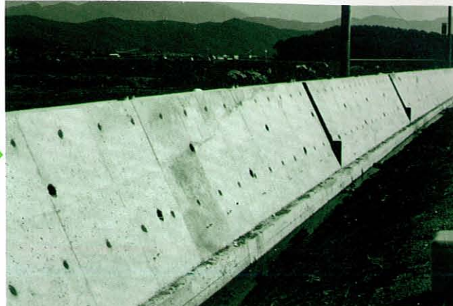
宅地造成工事のブロック積み擁壁
