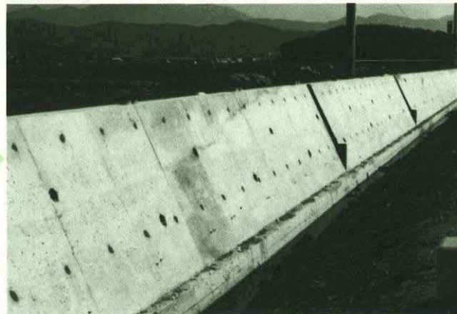
宅地造成工事のブロック積み擁壁
