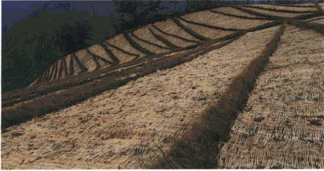
一里野スキー場(石川県)※土留めには植生土のうを使用しています。
