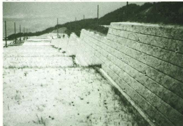
高速道路のもたれ擁壁、コンクリート吹付擁壁
