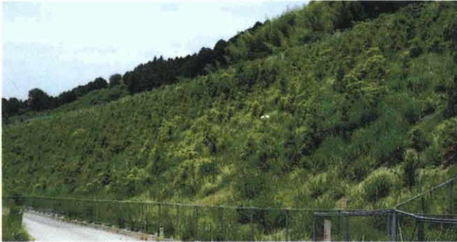
治山配合(高知県南国市)
