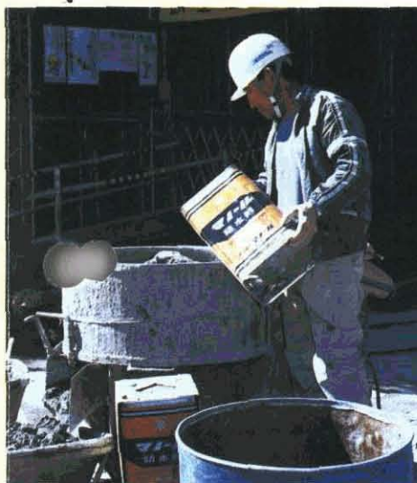
防水モルタルの現場混練
