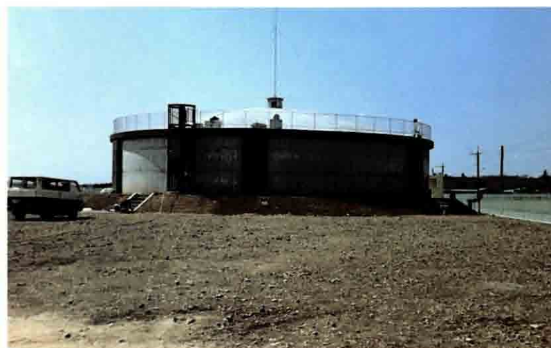
▲太田原市配水池PCタンク
