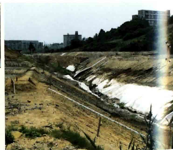
▲ 仮設盛土工事 ▶ まき出し土量の低減がはかれます。
