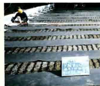
▲ 補強材テンサーを併用使用。 ▶ オーダスの排水機能とテンサーの補強機能により急勾配盛土が可能。
