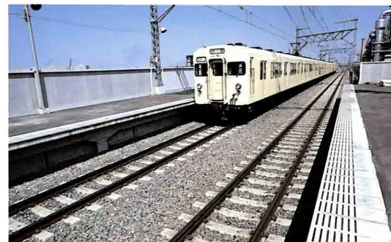
▲東武野田線高架橋
