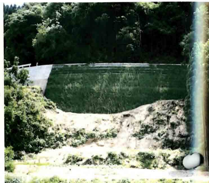
▲ 補強材テンサーを併用使用。 ▶ オーダスの排水機能とテンサーの補強機能により急勾配盛土が可能。
