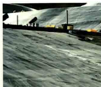
▲ 左側は遮水シート、右側がオーダス。 ▶ オーダスの保護効果により、遮水シートの破損を防止。
