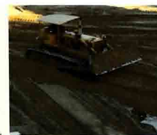
▲ 仮設盛土工事 ▶ まき出し土量の低減がはかれます。
