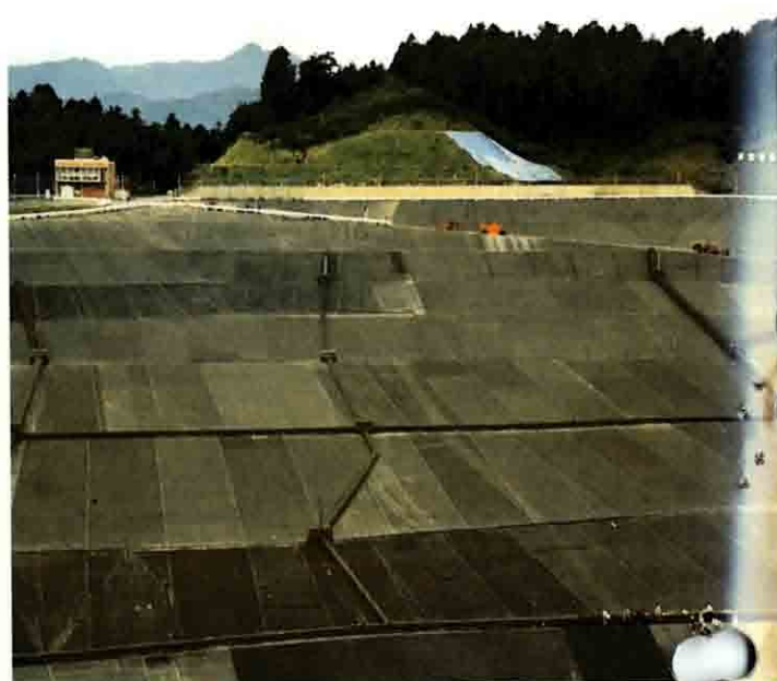
▲ 左側は遮水シート、右側がオーダス。 ▶ オーダスの保護効果により、遮水シートの破損を防止。
