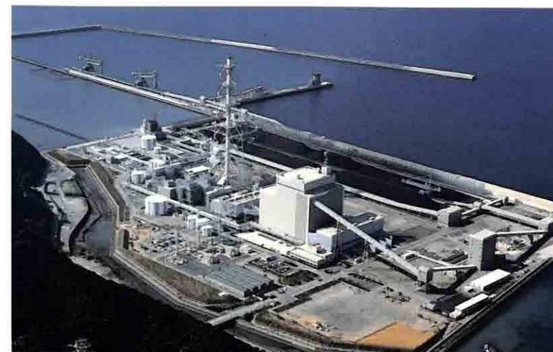
▲九州電力 苓北発電所
