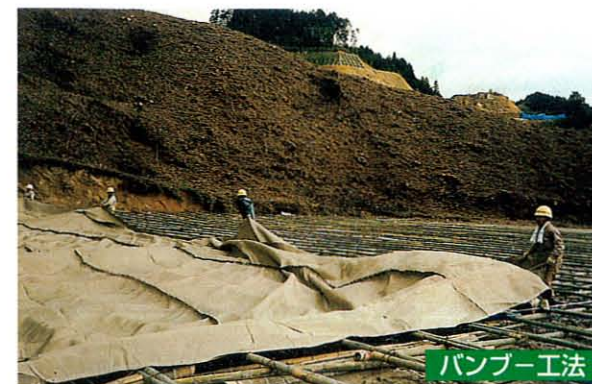
建設省霞ヶ浦 施工例(土木安定シート)
