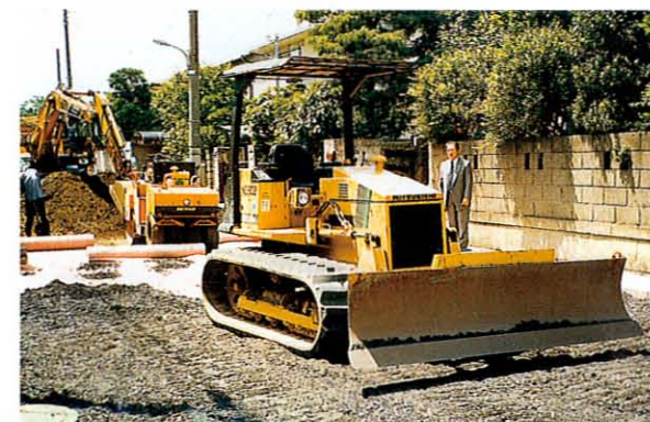
東京都大田区道路改良 施工例(トーアマット#100)
