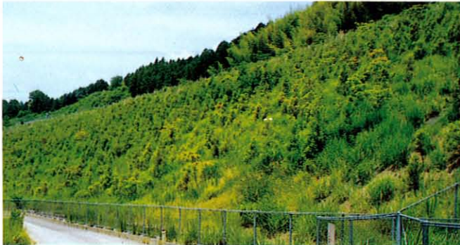
治山配合(高知県南国市)
