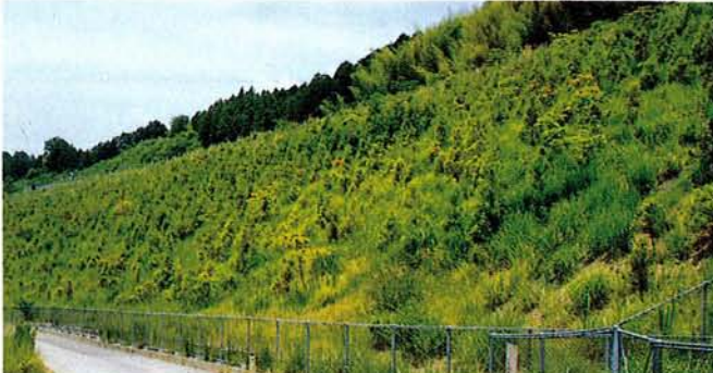
治山配合(高知県南国市)
