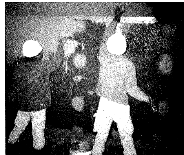
第6工程 防水材塗布
