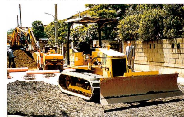
東京都大田区道路改良 施工例(トーママット#100)
