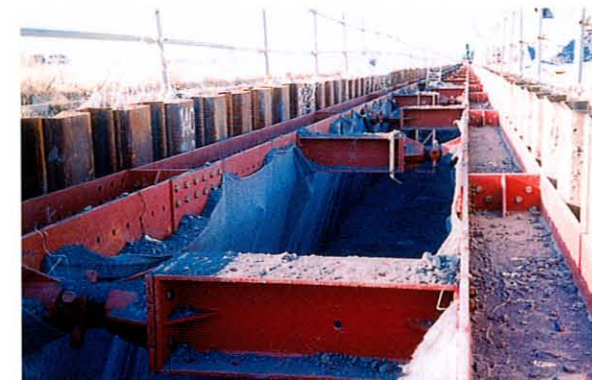
関東農政局農業水利事業 施工例(トーママットTH-5)
