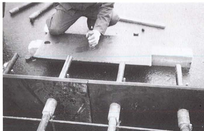
▲舗装膨張目地に使用
