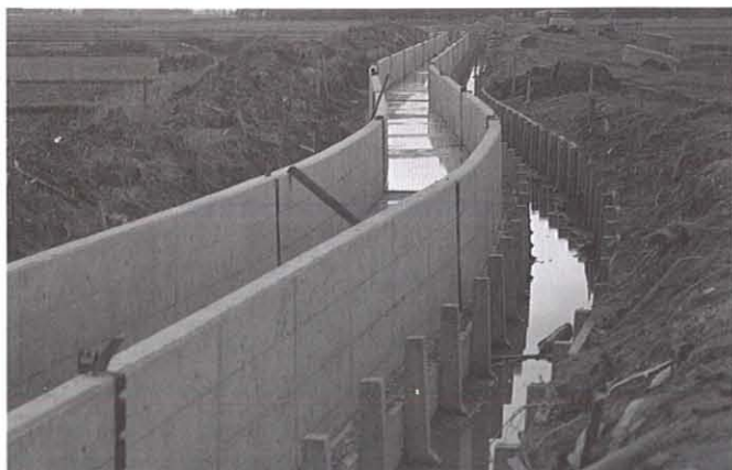
▲水路の目地に使用
