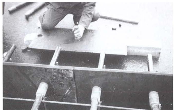
▲舗装膨張目地に使用
