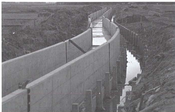
▲水路の目地に使用
