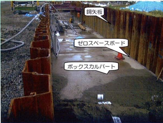
【構築完了】 補助材撤去後のボックスカルバートの状況
