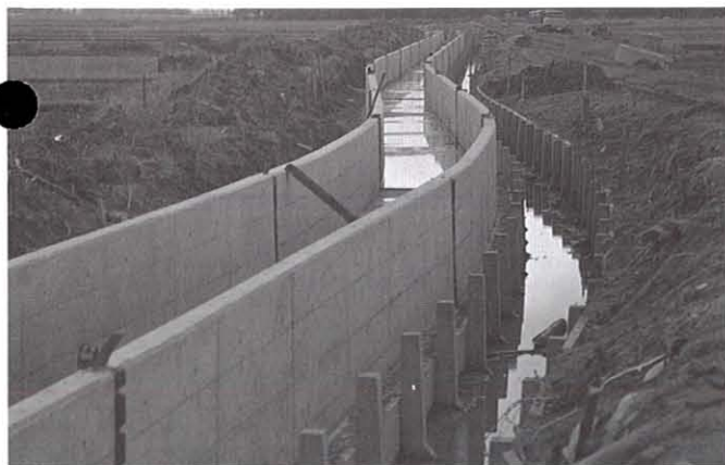
▲水路の目地に使用
