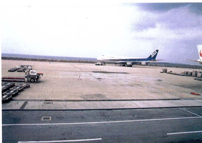
▲空港舗装の目地に使用
