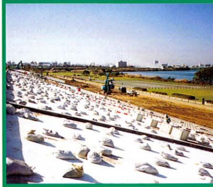
コーケンEV遮水シート (環境配慮型河川堤防用遮水シート)
