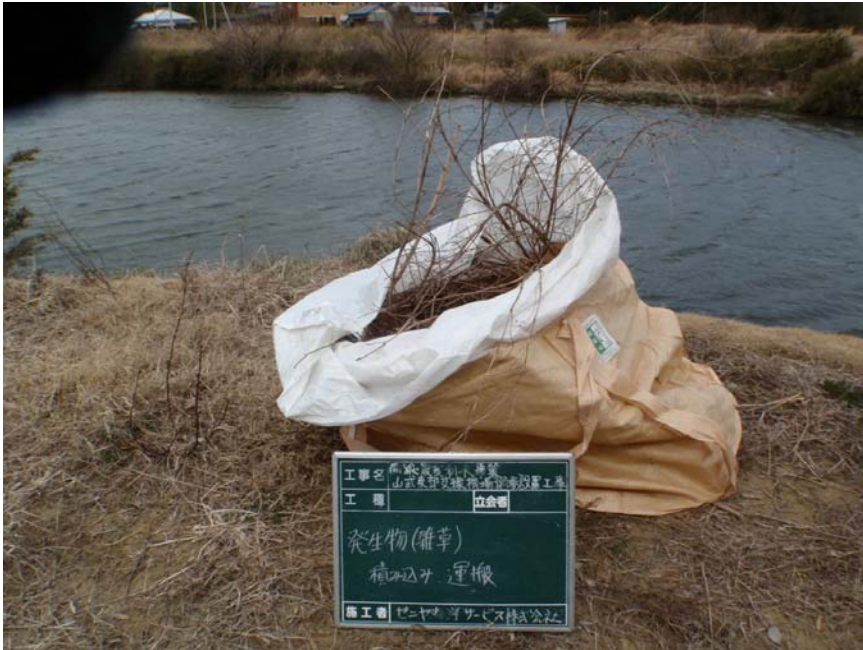
【写真タイトル】雑草除去 【写真 - 大分類】工事 【写真区分】その他 【請負者説明文】創意工夫 雑草集積状況
