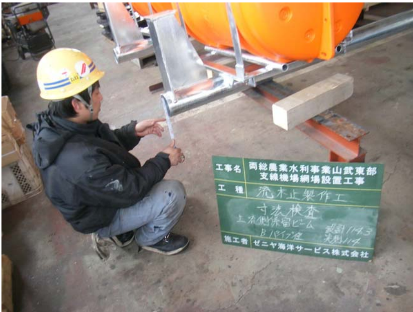
【写真タイトル】寸法検査（自主検査） 【写真 - 大分類】工事 【写真区分】施工状況写真 【工種】製作工 【種別】ビーム 【細別】上流側係留ビーム 【工種区分予備】パイプ径 設計値114.3 実測値114
