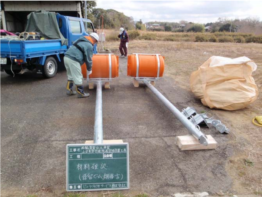
【写真タイトル】受入材料確認 【写真 - 大分類】工事 【写真区分】品質管理写真 【工種区分予備】係留ビム・網場一式
