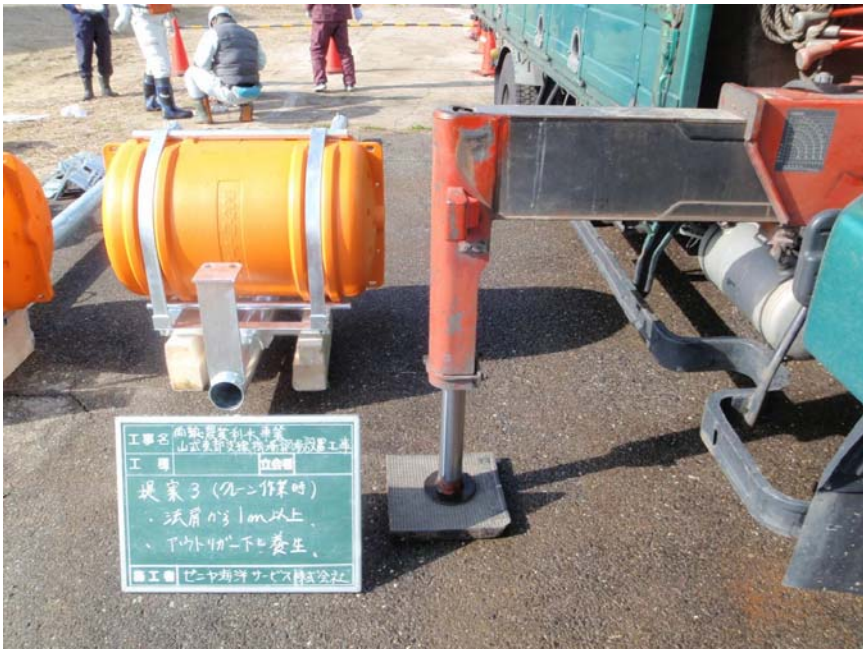
【写真タイトル】提案3： 法面崩壊、地盤陥没の対策 【写真 - 大分類】工事 【写真区分】施工状況写真 【工種区分予備】法面から1m以上離し、アウトリガー下には鉄板による養生
