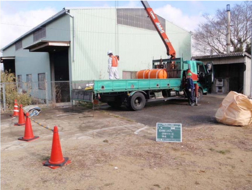
【写真タイトル】資材搬入状況 【写真 - 大分類】工事 【写真区分】施工状況写真
