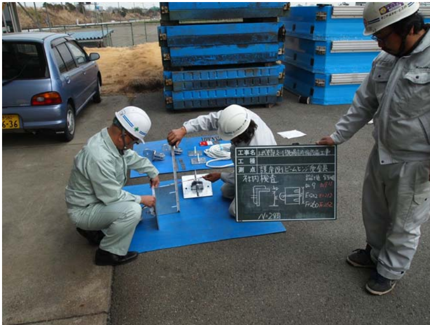
【写真タイトル】社内検査 【写真 - 大分類】工事 【写真区分】品質管理写真 【工種】製作工 【細別】護岸側ビームヒンジ受け金具
