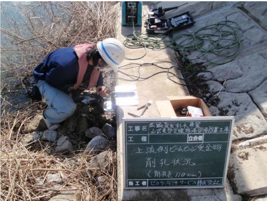
【写真タイトル】上流側 ビームヒンジ受金物 【写真 - 大分類】工事 【写真区分】施工状況写真 【工種区分予備】アンカ 一削孔状況 削孔長110mm
