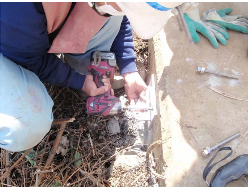
【写真タイトル】下流側 スーレ金物 【写真 - 大分類】工事 【写真区分】施工状況写 真 【工種区分予備】ケミカ ルアンカー打設状況
