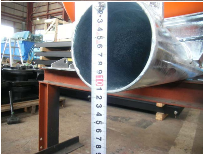
【写真タイトル】寸法検査（自主検査） 【写真 - 大分類】工事 【写真区分】施工状況写真 【工種】製作工 【種別】ビーム 【細別】下流側係留ビーム 【工種区分予備】パイプ径 設計値114.3 実測値114
