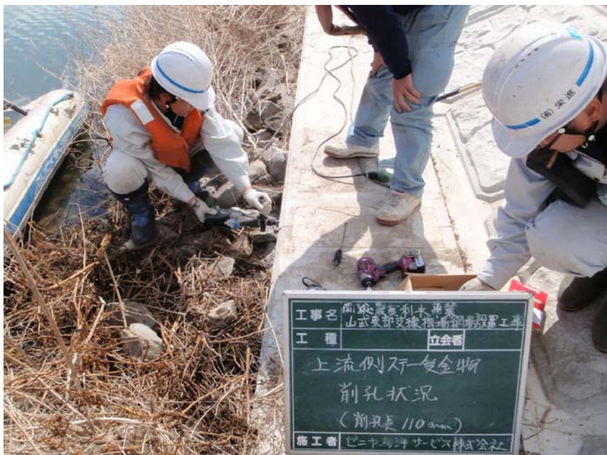
【写真タイトル】上流側 スレー金物 【写真 - 大分類】工事 【写真区分】施工状況写 真 【工種区分予備】アンカ ー削孔状況
