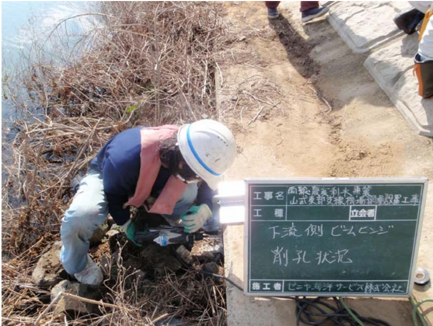
【写真タイトル】下流側 ビームヒンジ受金物 【写真 - 大分類】工事 【写真区分】施工状況写 真 【工種区分予備】アンカ ー削孔状況
