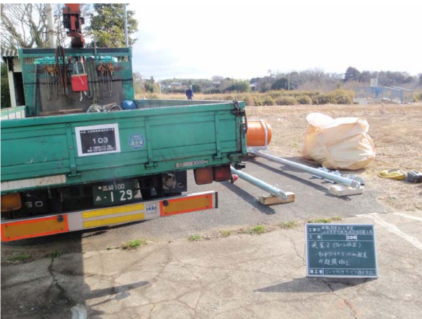
【写真タイトル】提案2： 据付時の重機配置に関する工夫 【写真 - 大分類】工事 【写真区分】施工状況写真 【工種区分予備】取水ゲ ートから10m程度の離隔を とる
