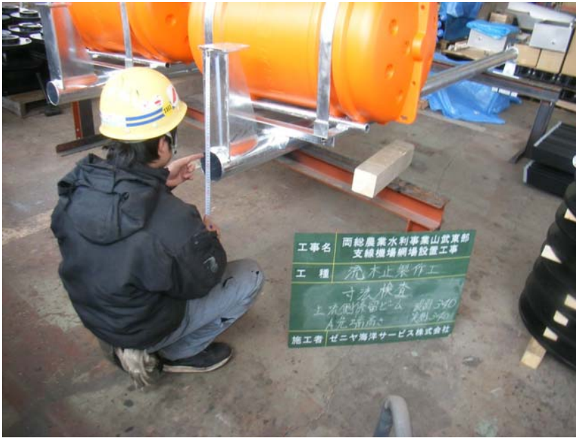
【写真タイトル】寸法検査（自主検査）
