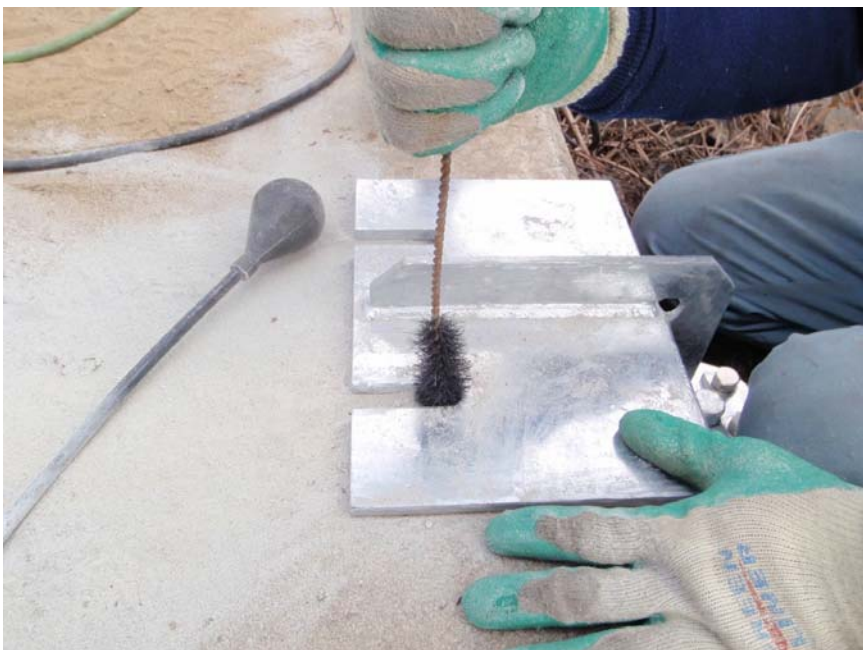
【写真タイトル】下流側 ビームヒンジ受金物 【写真 - 大分類】工事 【写真区分】施工状況写 真 【工種区分予備】ケミカ ルアンカー打設前清掃
