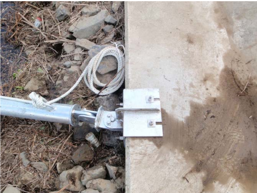
【写真タイトル】上流側 ビームヒンジ部設置状況 【写真 - 大分類】工事 【写真区分】施工状況写 真 【工種区分予備】設置完 了
