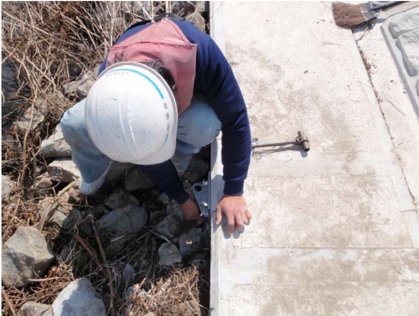
【写真タイトル】上流側 ステー金物 【写真 - 大分類】工事 【写真区分】施工状況写 真 【工種区分予備】ケミカ ルアンカー挿入状況
