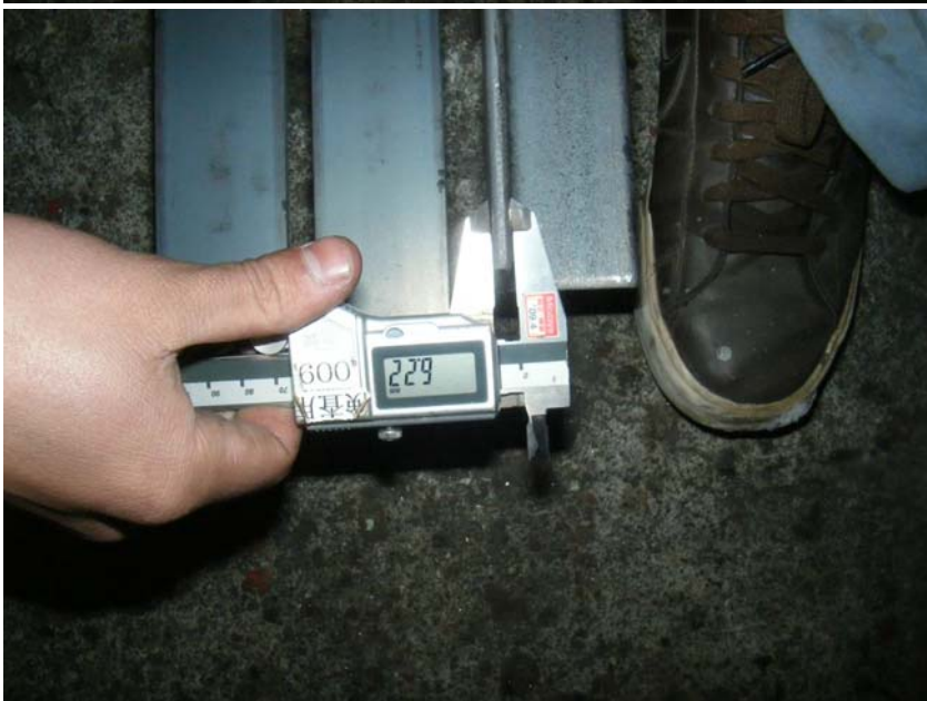
【写真タイトル】材料検査 【写真 - 大分類】工事 【写真区分】使用材料写真
