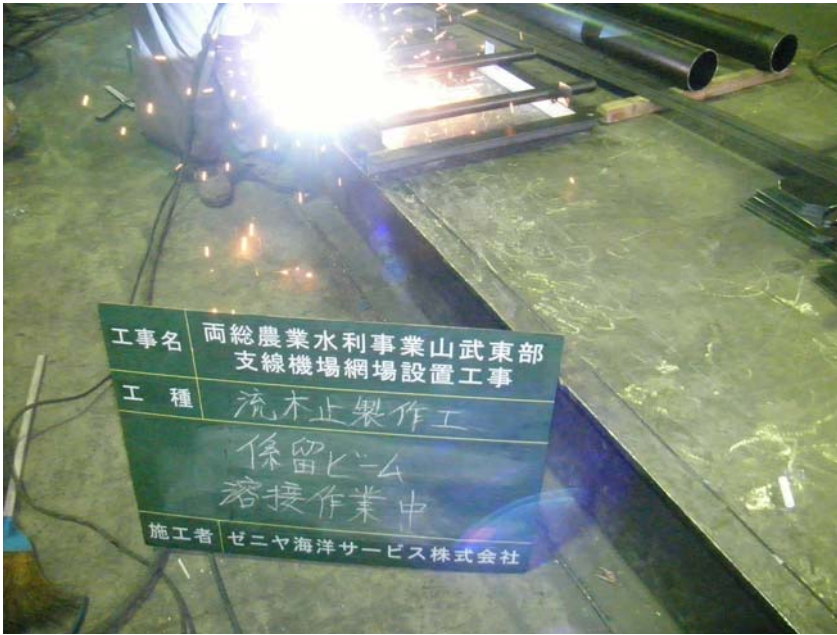
【写真タイトル】溶接作業中 【写真 - 大分類】工事 【写真区分】施工状況写真 【工種】製作工 【種別】ビーム 【細別】係留ビーム
