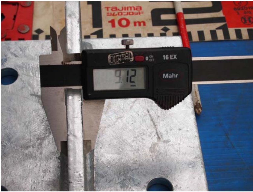
【写真タイトル】社内検査 【写真 - 大分類】工事 【写真区分】品質管理写真 【工種】製作工 【細別】護岸側ステー受金具 【工種区分予備】ステー連結部厚み 設計値9 実測値9.12
