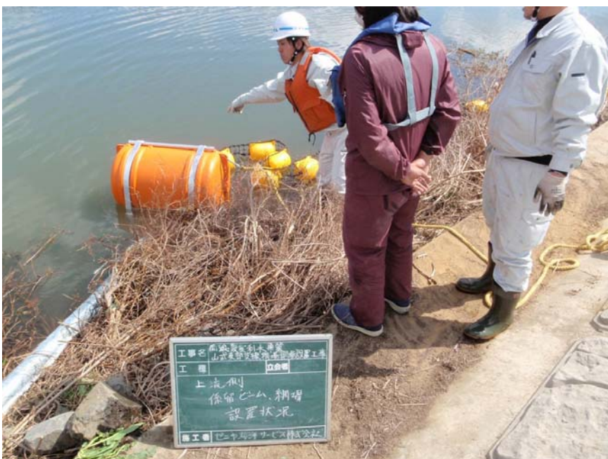
【写真タイトル】下流側 係留ビーム・網場設置状 況 【写真 - 大分類】工事 【写真区分】施工状況写 真
