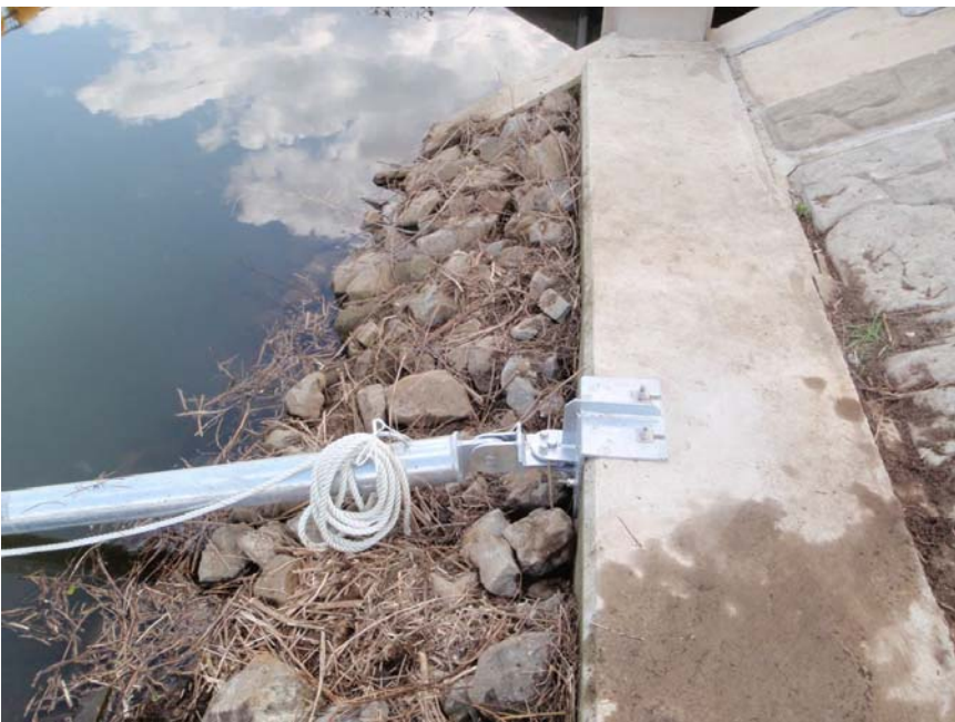
【写真タイトル】上流側 ビームヒンジ部結束状況 【写真 - 大分類】工事 【写真区分】施工状況写 真 【工種区分予備】設置完 了
