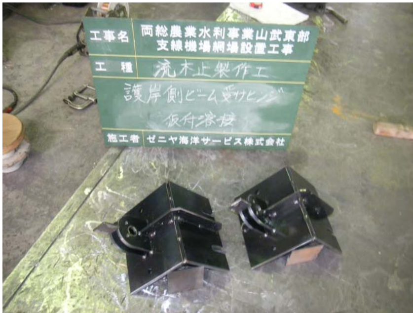
【写真タイトル】仮付溶接 【写真 - 大分類】工事 【写真区分】施工状況写真 【工種】製作工 【種別】ビーム 【細別】護岸側ビーム受けヒンジ
