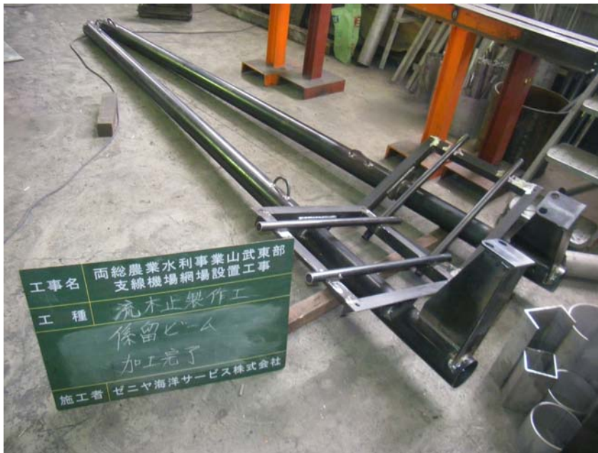
【写真タイトル】加工完了 【写真 - 大分類】工事 【写真区分】施工状況写真 【工種】製作工 【種別】ビーム 【細別】係留ビーム
