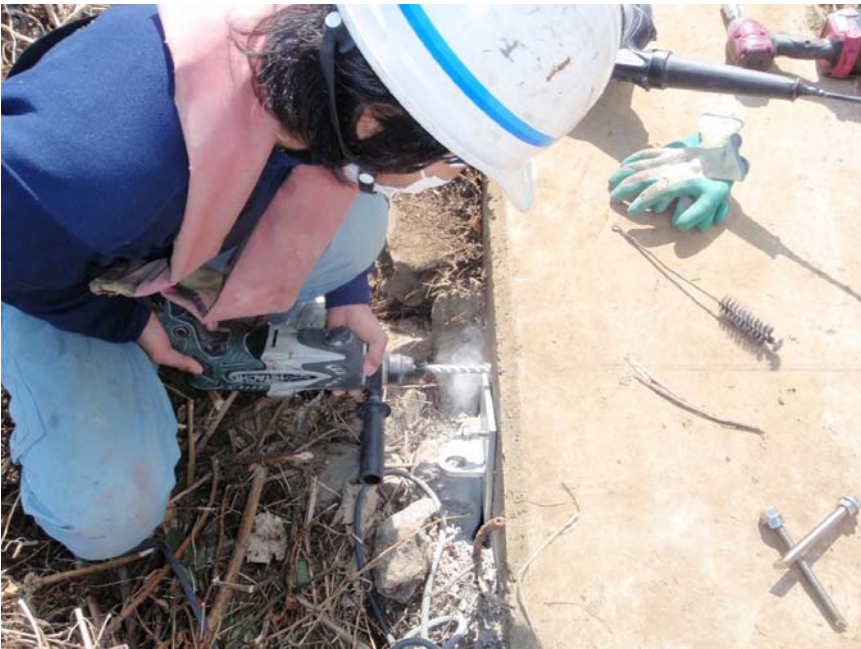
【写真タイトル】下流側 ステー金物 【写真 - 大分類】工事 【写真区分】施工状況写 真 【工種区分予備】アンカ ー削孔状況
