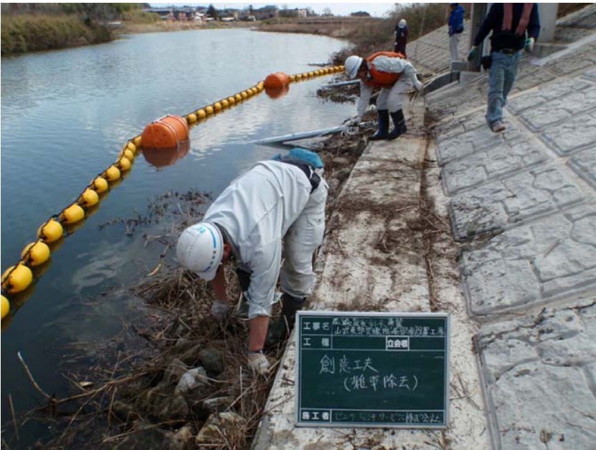
【写真タイトル】 雑草除去 【写真 - 大分類】 工事 【写真区分】 その他 【請負者説明文】 創意工夫 作業状況
