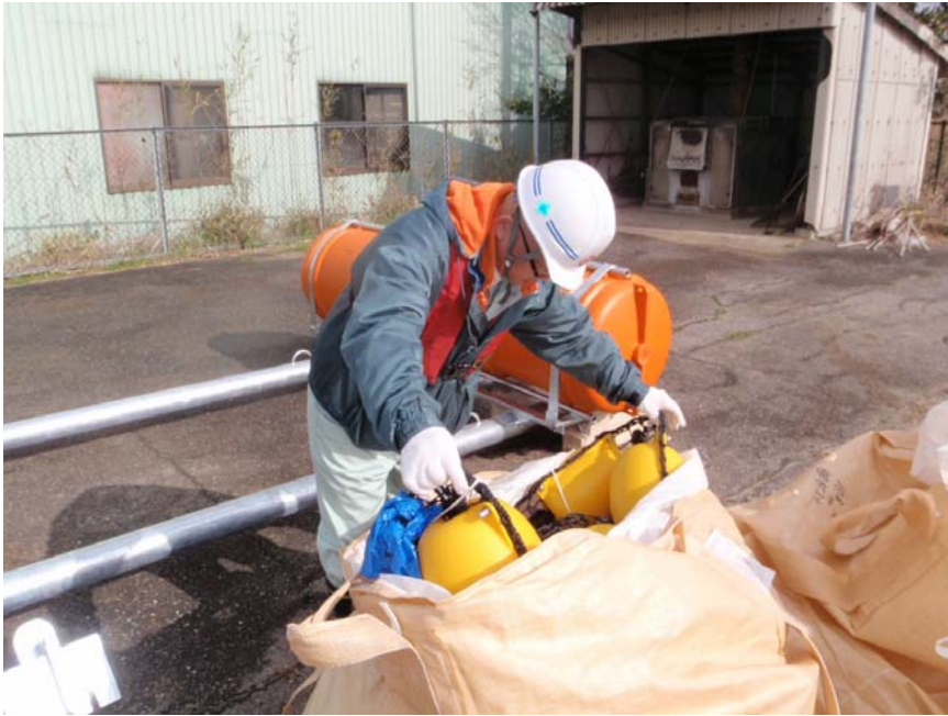
【写真タイトル】受入材料確認 【写真 - 大分類】工事 【写真区分】品質管理写真 【工種区分予備】網場資材の確認
