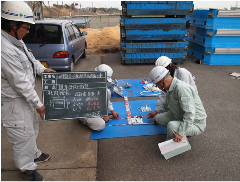
【写真タイトル】社内検査 【写真 - 大分類】工事 【写真区分】品質管理写真 【工種】製作工 【細別】護岸側ステータ受金具
