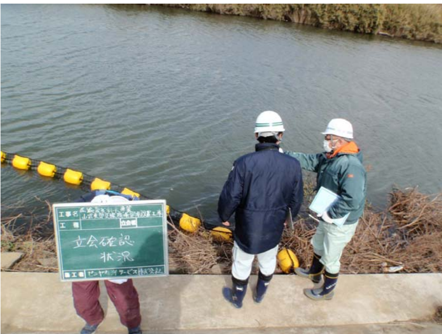
【写真タイトル】立会確認 【写真 - 大分類】工事 【写真区分】出来形管理 写真 【工種】据付工 【工種区分予備】材料及 び結束状況の確認
