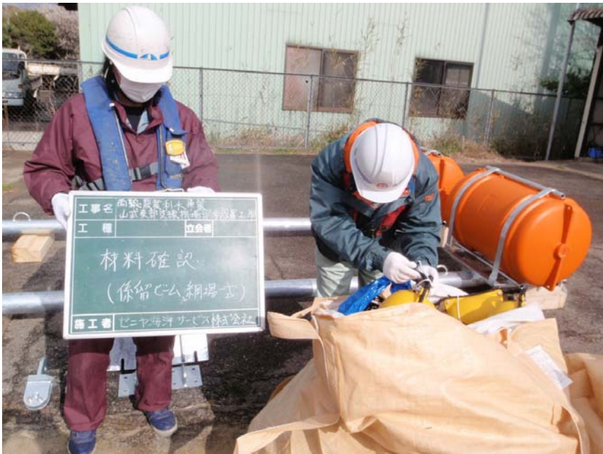
【写真タイトル】受入材料確認 【写真 - 大分類】工事 【写真区分】品質管理写真 【工種区分予備】網場資材の確認
