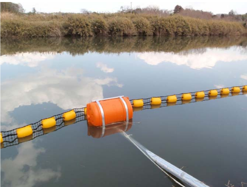
【写真タイトル】ビーム 先端部設置状況 【写真 - 大分類】工事 【写真区分】施工状況写 真 【工種区分予備】設置完 了
