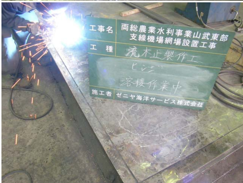
【写真タイトル】溶接作業中 【写真 - 大分類】工事 【写真区分】施工状況写真 【工種】製作工 【種別】ビーム 【細別】ヒンジ
