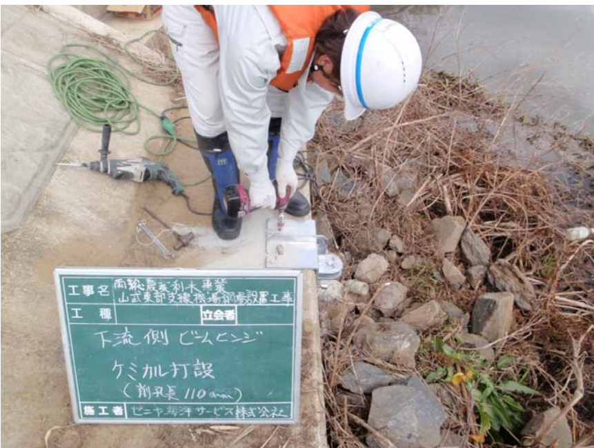
【写真タイトル】下流側 ビームヒンジ受金物 【写真 - 大分類】工事 【写真区分】施工状況写真 【工種区分予備】アンカー設置状況
