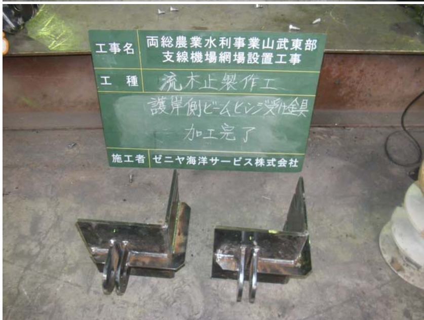
【写真タイトル】加工完了 【写真 - 大分類】工事 【写真区分】施工状況写真 【工種】製作工 【種別】ビーム 【細別】護岸側ビームヒンジ受け金具
