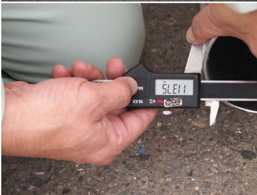
【写真タイトル】社内検査 【写真 - 大分類】工事 【写真区分】品質管理写真 【工種】製作工 【細別】係留ビーム（上流側） 【工種区分予備】パイプ径 設計値114.3 実測値113.75
