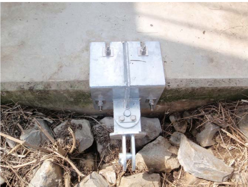
【写真タイトル】上流側 ビームヒンジ受金物 【写真 - 大分類】工事 【写真区分】施工状況写 真 【工種区分予備】アンカ ー設置完了
