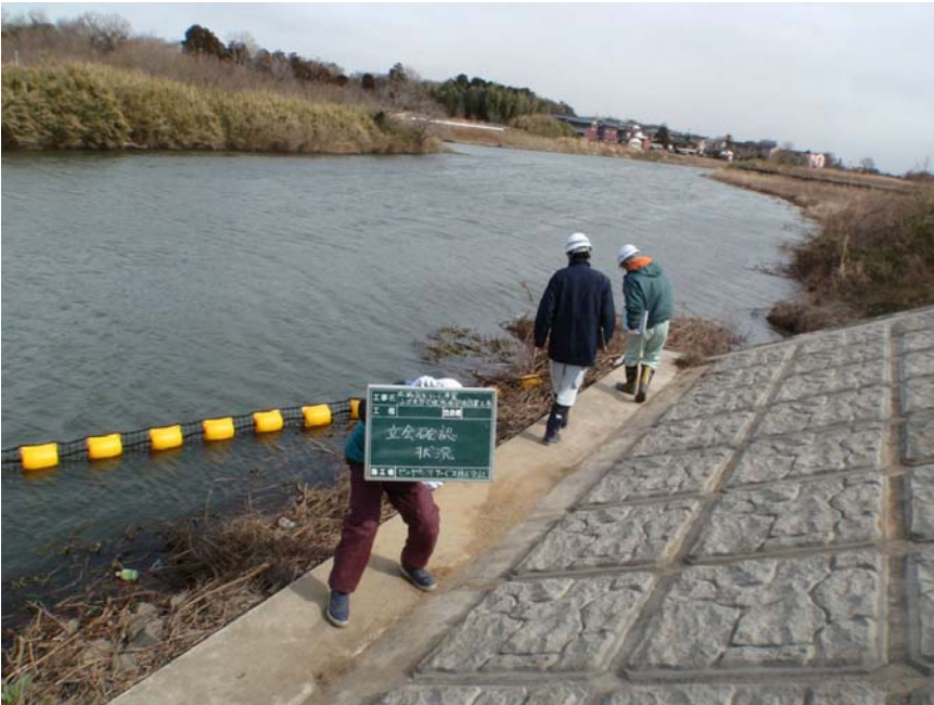
【写真タイトル】立会確認 【写真 - 大分類】工事 【写真区分】出来形管理 写真 【工種】据付工 【工種区分予備】材料及 び結束状況の確認 【撮影年月日】20110316
