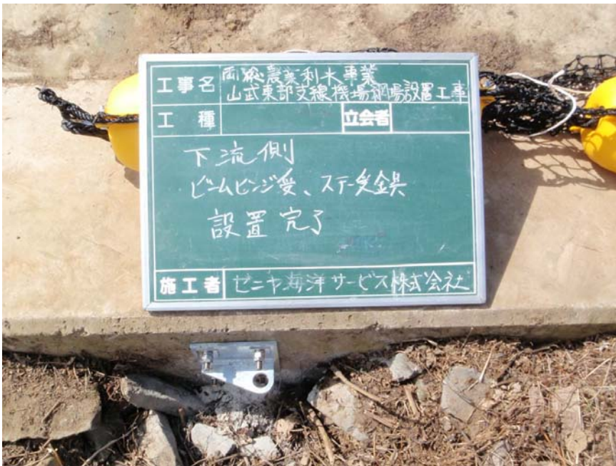
【写真タイトル】下流側 ステー金物 【写真 - 大分類】工事 【写真区分】施工状況写 真 【工種区分予備】設置完 了
