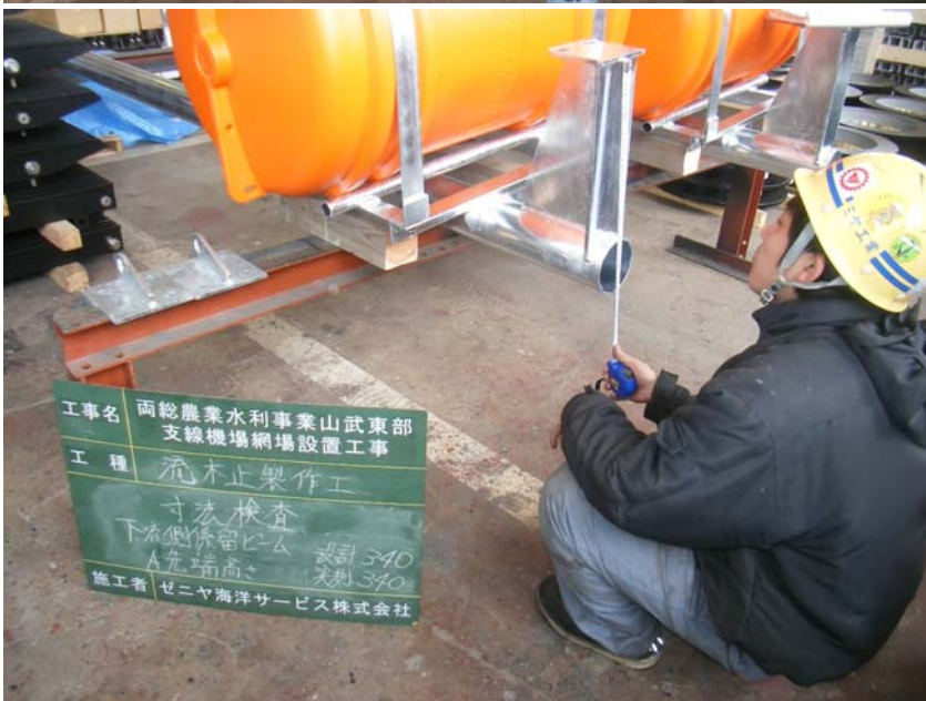
【写真タイトル】寸法検査（自主検査）
