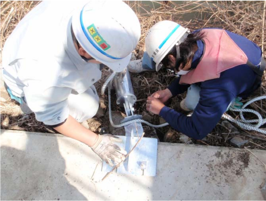
【写真タイトル】上流側 係留ビーム・網場設置状 況
