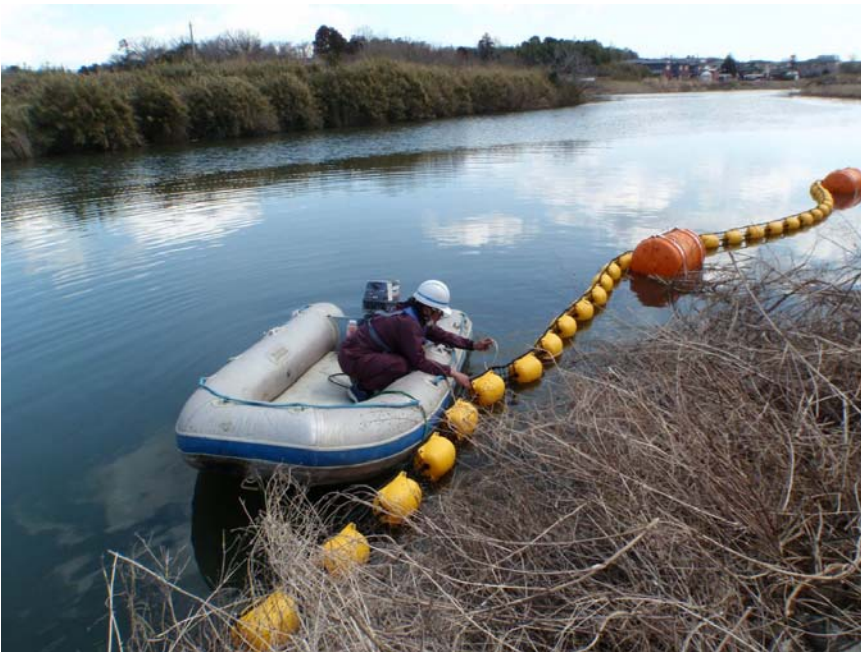
【写真タイトル】提案1： 網場据付に対する工夫 【写真 - 大分類】工事 【写真区分】施工状況写真 【工種区分予備】たくし 上げたネットを降ろして いる状況
