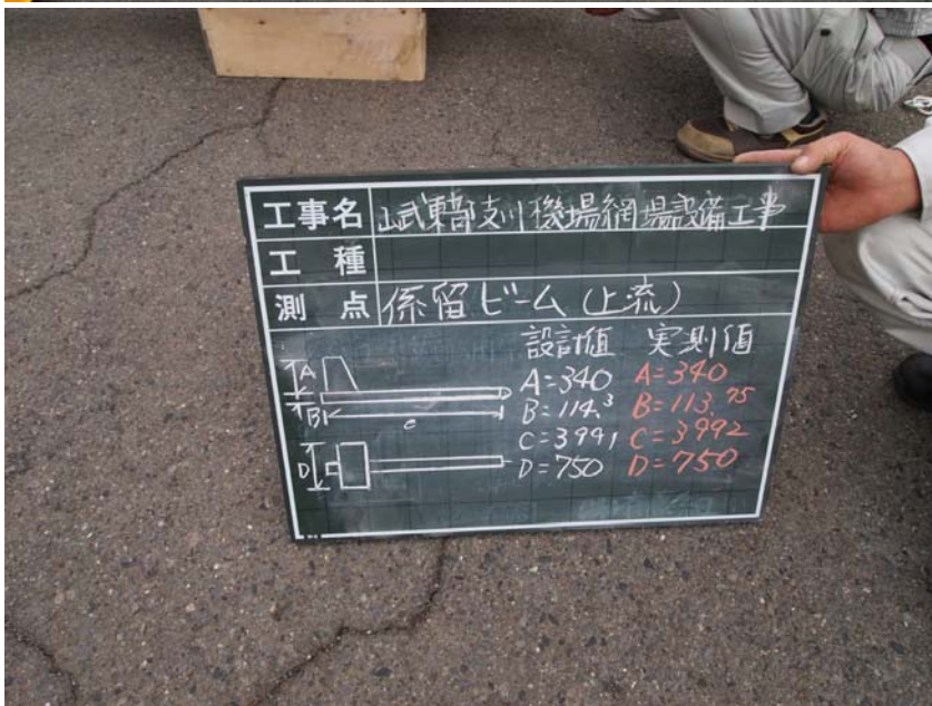
【写真タイトル】社内検査 【写真 - 大分類】工事 【写真区分】品質管理写真 【工種】製作工 【細別】係留ビーム（上流側） 【工種区分予備】全長 設計値3991 実測値3992
