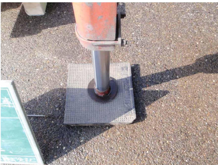
【写真タイトル】提案3： 法面崩壊、地盤陥没の対策 【写真 - 大分類】工事 【写真区分】施工状況写真 【工種区分予備】法面から1m以上離し、アウトリガー下には鉄板による養生
