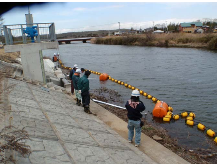
【写真タイトル】立会確認 【写真 - 大分類】工事 【写真区分】出来形管理 写真 【工種】据付工 【工種区分予備】動作説 明会
