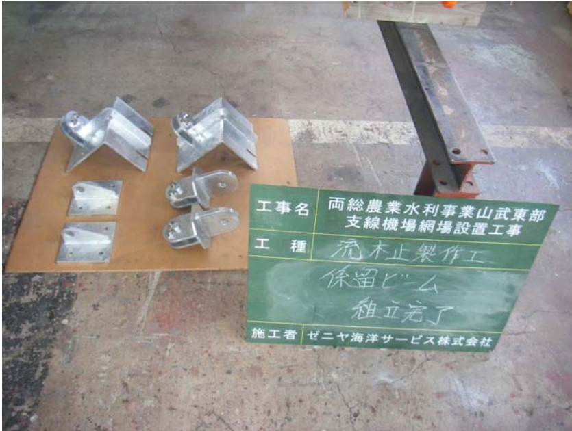
【写真タイトル】組立完了 【写真 - 大分類】工事 【写真区分】施工状況写真 【工種】製作工 【種別】ビーム 【細別】係留ビーム
