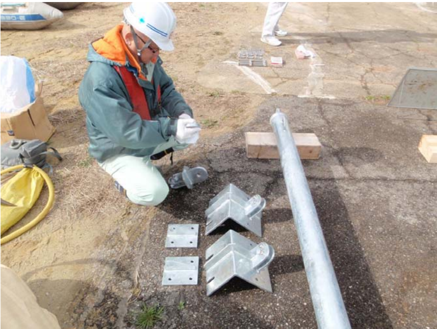
【写真タイトル】受入材料確認 【写真 - 大分類】工事 【写真区分】品質管理写真 【工種区分予備】係留金 具確認
