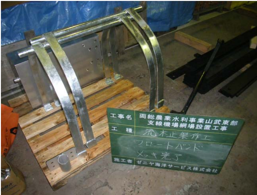
【写真タイトル】メッキ完了 【写真 - 大分類】工事 【写真区分】施工状況写真 【工種】製作工 【種別】ビーム 【細別】フロートバンド
