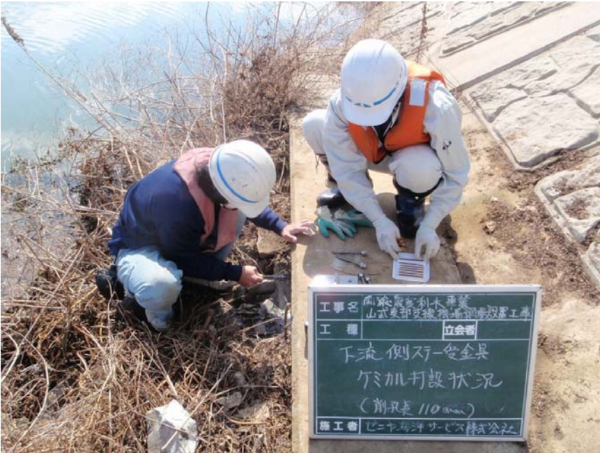
【写真タイトル】下流側 スーレ金物 【写真 - 大分類】工事 【写真区分】施工状況写 真 【工種区分予備】ケミカ ルアンカー打設前清掃
