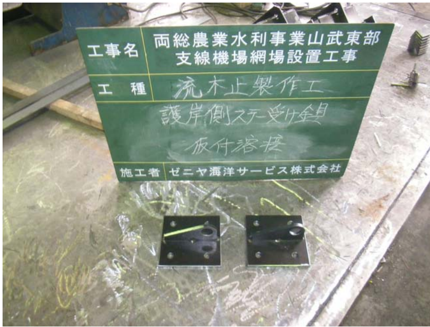
【写真タイトル】仮付溶接 【写真 - 大分類】工事 【写真区分】施工状況写真 【工種】製作工 【種別】ビーム 【細別】護岸側ステー受け金具
