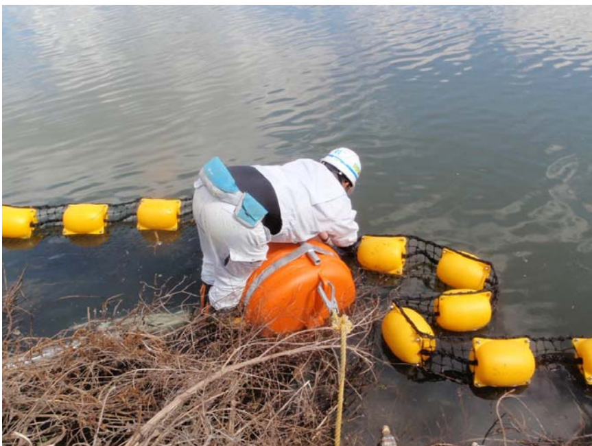
【写真タイトル】下流側 係留ビーム・網場設置状 況
