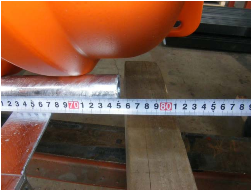
【写真タイトル】寸法検査（自主検査） 【写真 - 大分類】工事 【写真区分】施工状況写真 【工種】製作工 【種別】ビーム 【細別】上流側係留ビーム 【工種区分予備】ブラケット高さ 設計値750 実測値750
