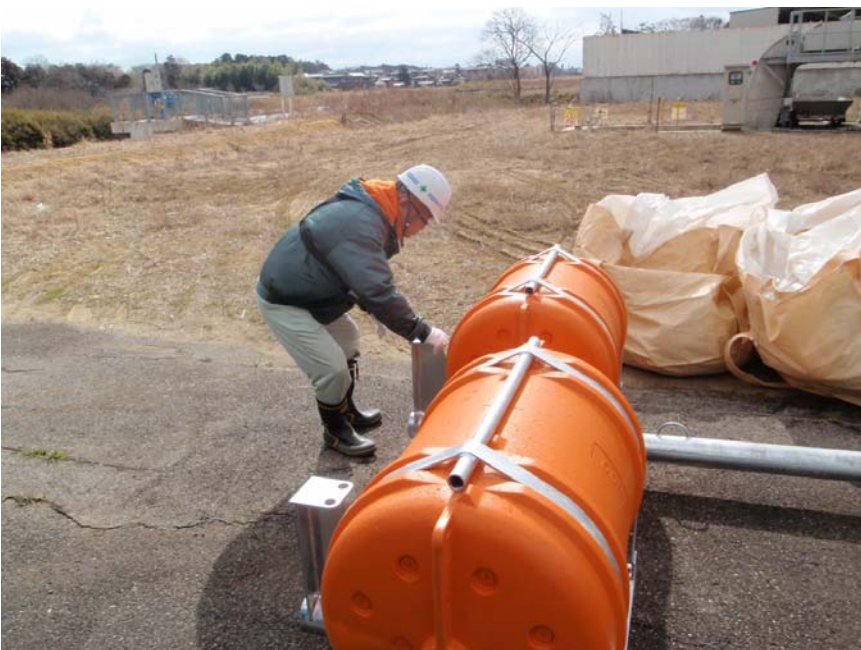
【写真タイトル】受入材料確認 【写真 - 大分類】工事 【写真区分】品質管理写真 【工種区分予備】係留ビム先端状況確認
