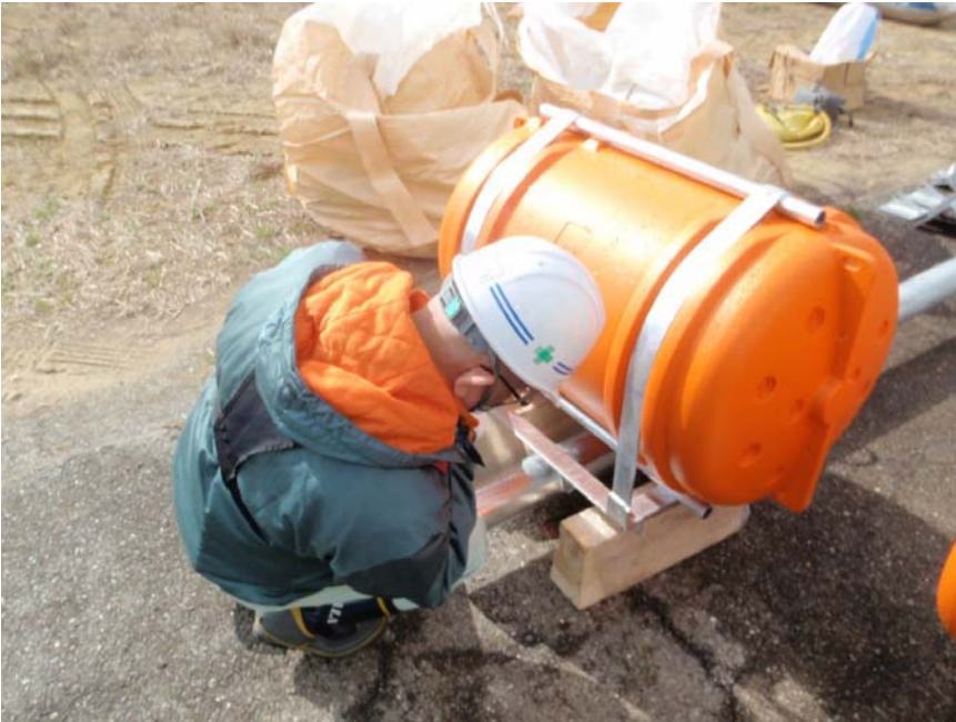
【写真タイトル】受入材料確認 【写真 - 大分類】工事 【写真区分】品質管理写真 【工種区分予備】係留ピ ーム先端状況確認
