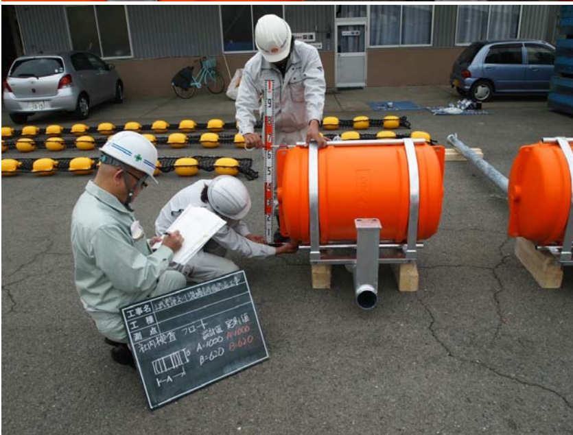
【写真タイトル】社内検査 【写真 - 大分類】工事 【写真区分】品質管理写真 【工種】製作工 【細別】フロート 【工種区分予備】直径 設計値620 実測値620
