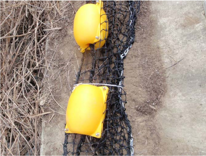
【写真タイトル】提案1： 網場据付に対する工夫 【写真 - 大分類】工事 【写真区分】施工状況写真 【工種区分予備】網場を 仮設ロープによりたくし 上げておく
