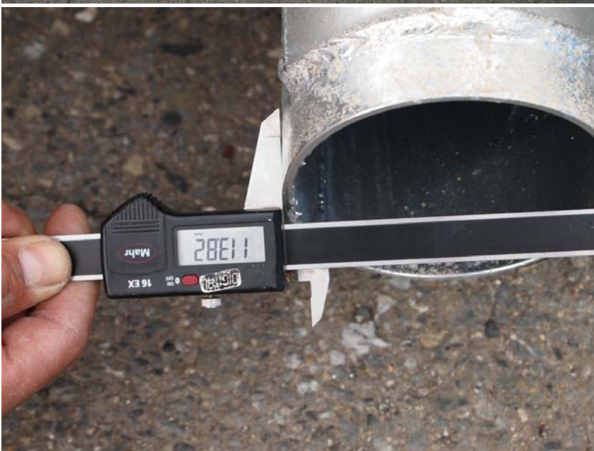
【写真タイトル】社内検査 【写真 - 大分類】工事 【写真区分】品質管理写真 【工種】製作工 【細別】係留ビーム（下流側） 【工種区分予備】パイプ径 設計値114.3 実測値113.82
