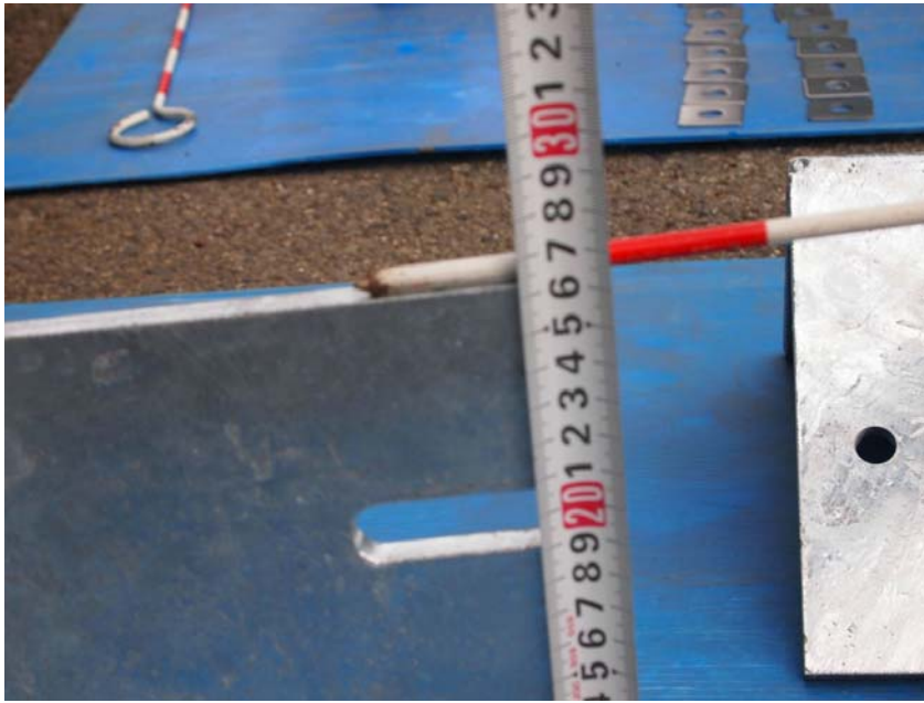
【写真タイトル】社内検査 【写真 - 大分類】工事 【写真区分】品質管理写真 【工種】製作工 【細別】護岸側ビームヒンジ受け金具 【工種区分予備】ヒンジ幅 設計値260 実測値262
