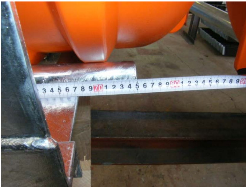
【写真タイトル】寸法検査（自主検査） 【写真 - 大分類】工事 【写真区分】施工状況写真 【工種】製作工 【種別】ビーム 【細別】下流側係留ビーム 【工種区分予備】ブラケット高さ 設計値750 実測値750
