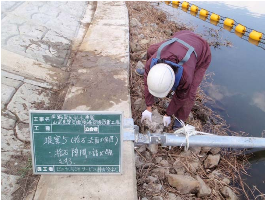
【写真タイトル】提案5： 捨石法面の保護対策 【写真 - 大分類】工事 【写真区分】施工状況写真 【工種区分予備】捨て石 隙間に詰め物をし安定させる
