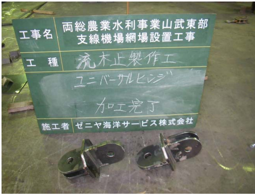
【写真タイトル】加工完了 【写真 - 大分類】工事 【写真区分】施工状況写真 【工種】製作工 【種別】ビーム 【細別】ユニバーサルヒンジ
