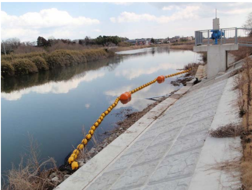
【写真タイトル】雑草除去 【写真 - 大分類】工事 【写真区分】その他 【請負者説明文】作業後 状況
