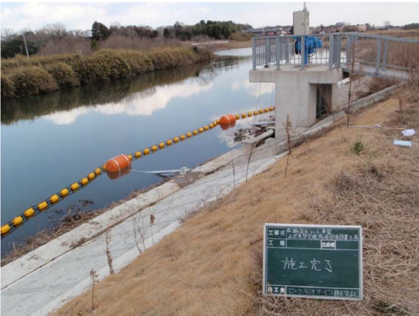
【写真タイトル】網場設置状況 【写真 - 大分類】工事 【写真区分】施工状況写真 【工種区分予備】設置完了 上流側から望む
