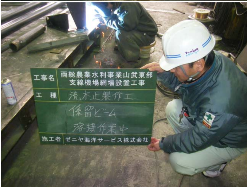
【写真タイトル】仮付溶接 【写真 - 大分類】工事 【写真区分】施工状況写真 【工種】製作工 【種別】ビーム 【細別】係留ビーム
