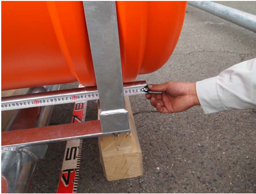
【写真タイトル】社内検査 【写真 - 大分類】工事 【写真区分】品質管理写真 【工種】製作工 【細別】係留ビーム（上流側） 【工種区分予備】ブラケット高さ 設計値750 実測値750
