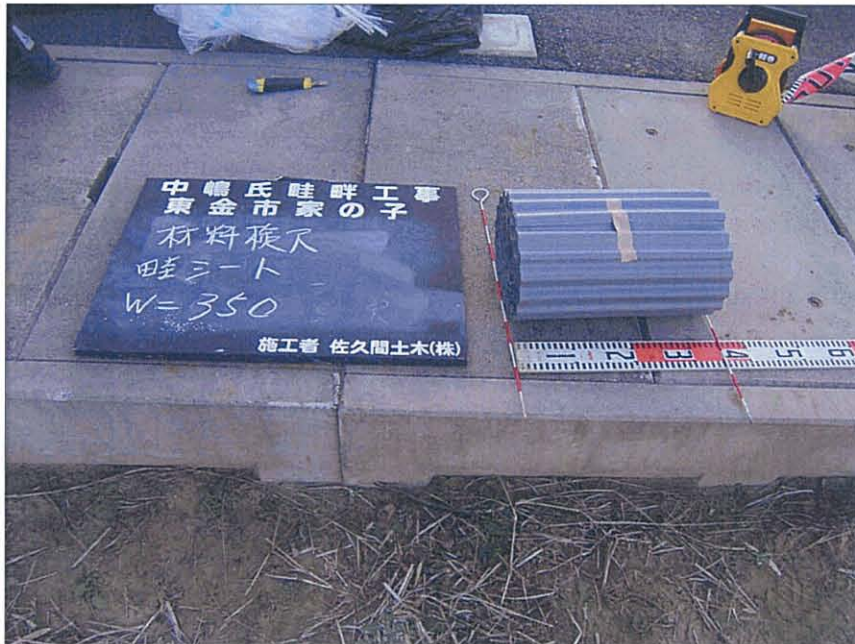
写真区分：施工状況写真 工種：波板設置工 写真タイトル：使用材料(波板)
