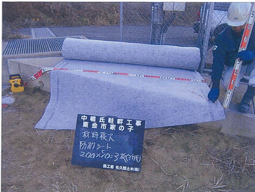
写真区分：施工状況写真 工種：柵渠吸い出し復旧工 写真タイトル：使用材料(吸出し防止シート)
